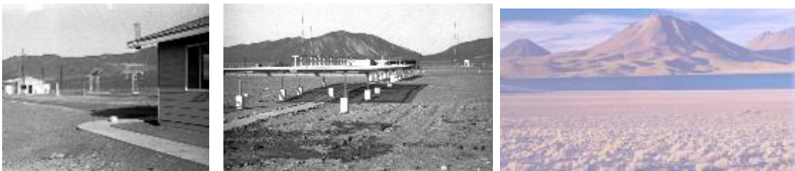
Antofagasta – Chile – edificio de operaciones y antena “minitrack” – Salar del Carmen - Web
