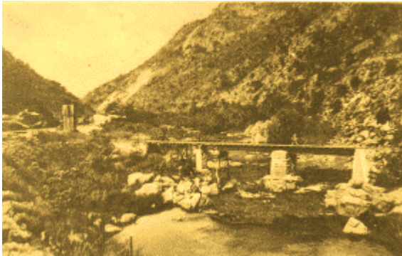
Casa Bamba – izquierda – y dique San Roque - Web
