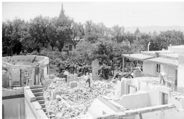
Demolición del viejo edificio – Córdoba Estelar
