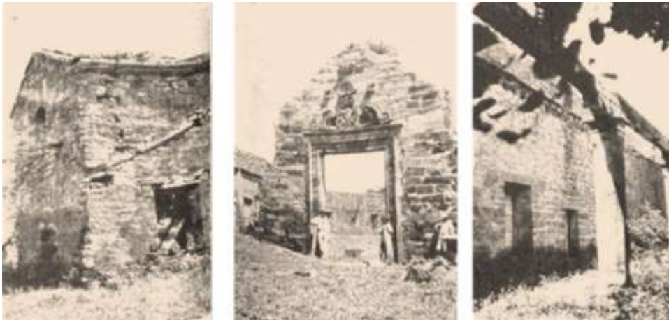
San Cosme - Parte posterior, entrada al patio central y galería posterior sobre barranca del río Paraná.
