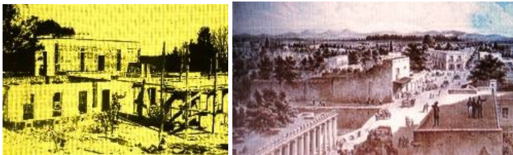
Observatorio de Tacubaya en construcción- UNAM – Tacubaya del Siglo XIX - Web
