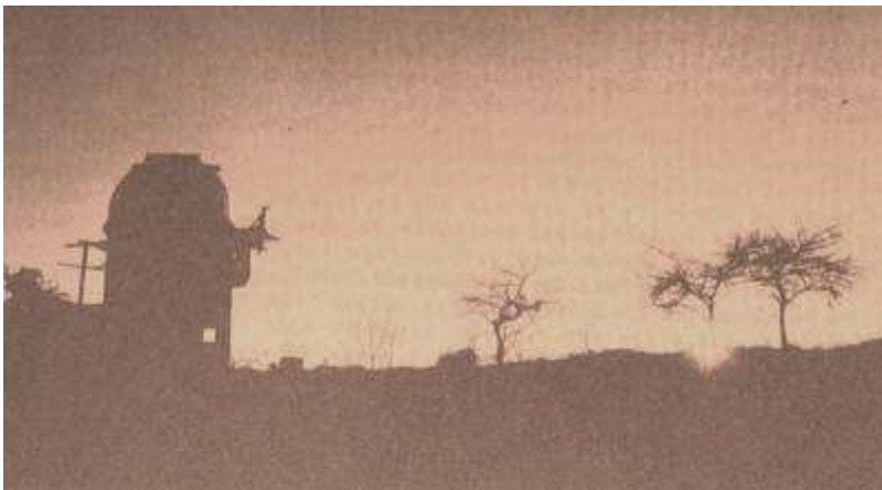
El Observatorio en la etapa constructiva - Revista Universo - LIADA
