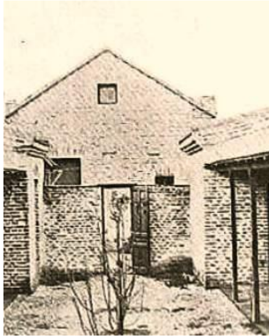
Puerta de acceso de las dependencias a los albergues instrumentales
