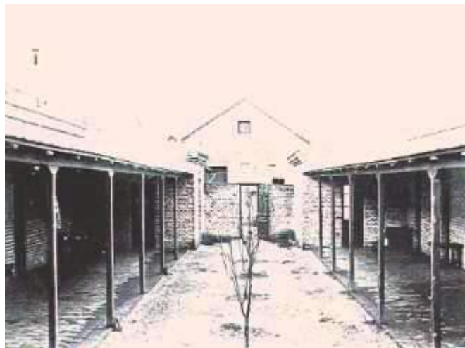
Galerías al frente de los dormitorios del personal
