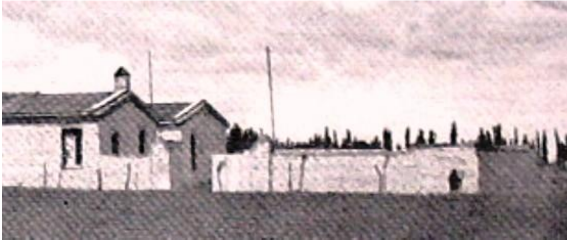
Sector de la Escuela afectada
